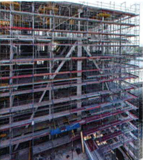
Humboldt/HafenEins Megatruss (Foto: Bilfinger)
