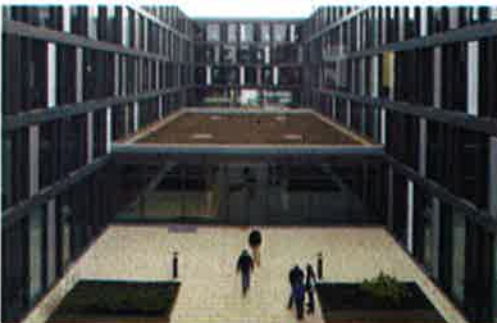
BASF Rheinufer Süd Innenhof (Foto: Bilfinger)
